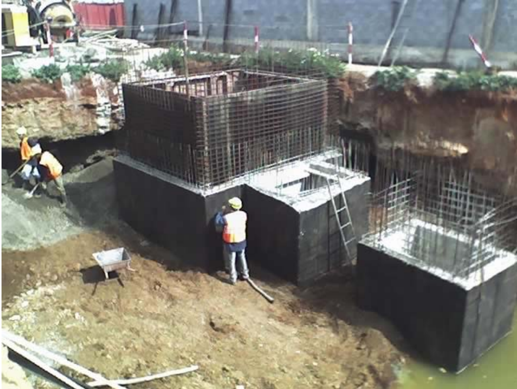
Figure 3 : Photo sur la construction de la station de refoulement -
