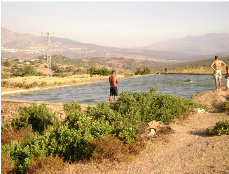
Photo n° 3 : Bassin de réception de l'eau destinée à l'irrigation 01-8-2007
